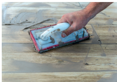
Spoinowanie metodą szlamowania
