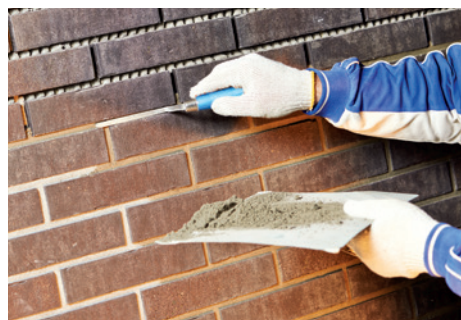
Spoinowanie za pomocą kielni do spoin
