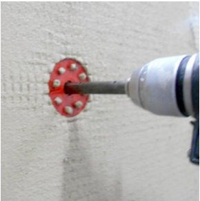
Montaż łączników mechanicznych
