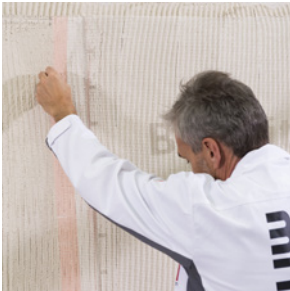
Układanie siatki Startex Grob
